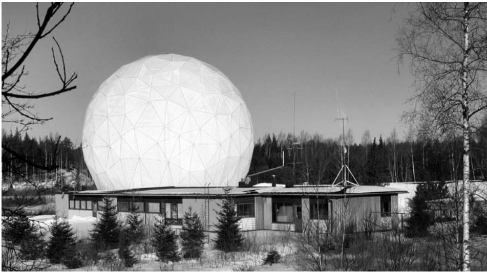
Kuva 2. Metsähovin 13,7 metrin radioteleskooppi. Teleskoopilla tehdään myös geodeettisia VLBI-havainnoja. (Kuva: M. Poutanen)
