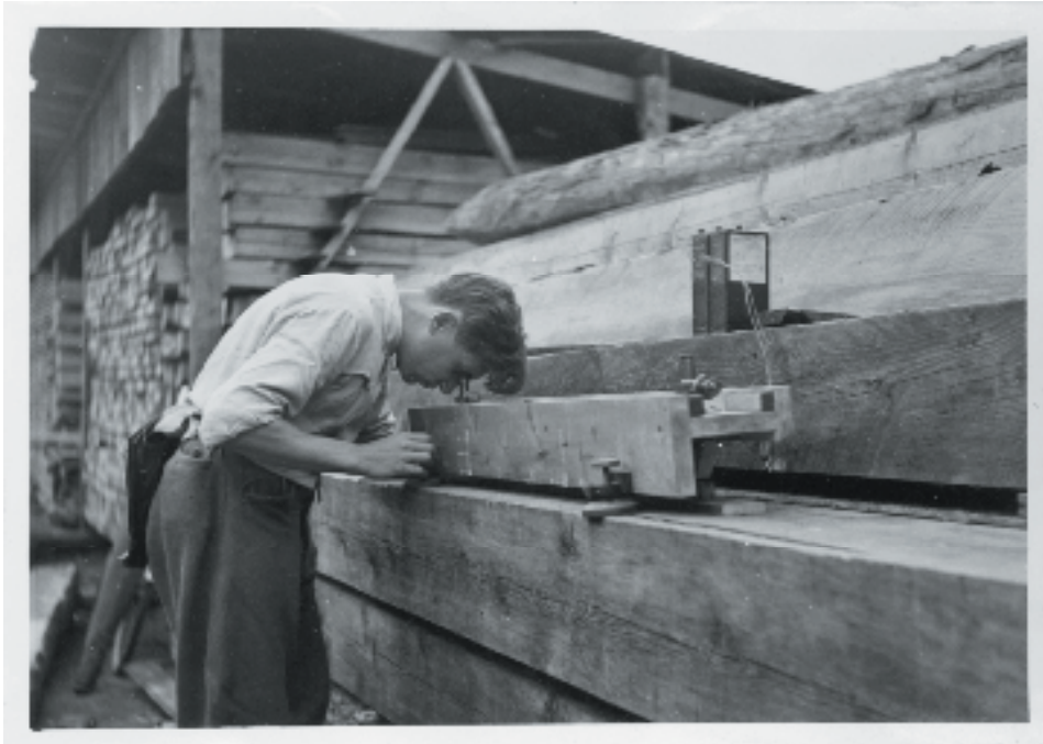
Kuva 6. Geodeettisen laitoksen mikroskooppikomparaattori. Laitetta käytettiin Suomen Toisessa tarkkavaaituksessa latta-asteikkojen ja mittanormaalien kalibrointiin vuosina 1935–1970. Kuvassa ylioppilas E. Hänninen on suorittamassa lattojen kalibrointia Pieksämäellä 1945. (Kuva: E. Kääriäinen)
