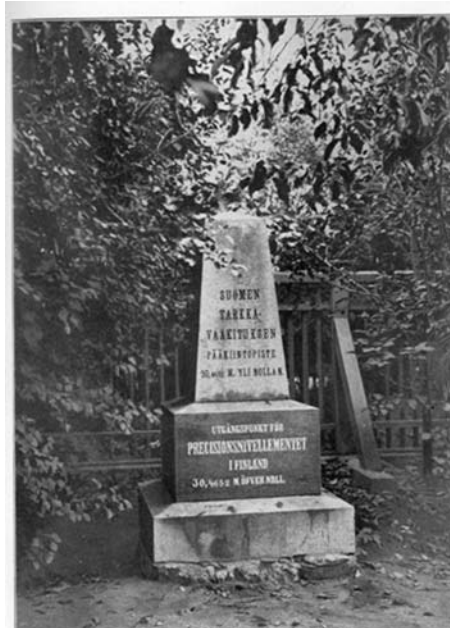
Kuva 1. Suomen valtakunnallisen tarkkavaaituksen pääkiintopiste. Kuva on julkaisusta: Suomen Tie- ja Vesirakennusten Ylihallitus (1910) "Suomen Tarkkavaaaitus 1892-1910".
